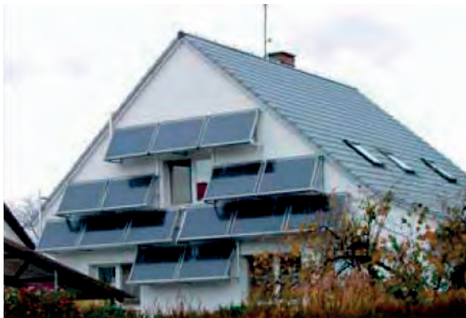
Kolektory se směřují k jihu (mírně k jihozápadu, aby se využilo i zapadající slunce). Mají být ve sklonu kolem 45°, někdy se ke Slunci natačejí. Při celodenním svitu je nejvyšší výkon kolem 14 hodiny.
