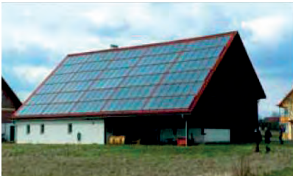
Výtopna na dřevo doplněná solárním systémem pro letní provoz
