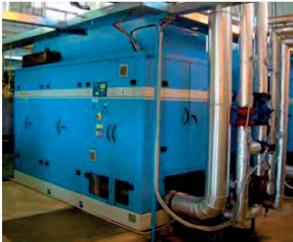
Kogenerační jednotka přeměňuje bioplyn na elektřinu a teplo Foto: Jiří Beranovský, EkoWATT
