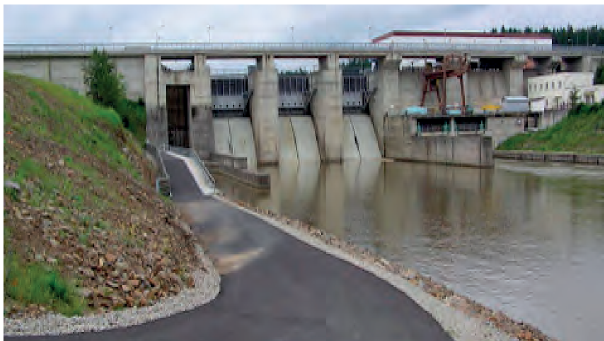
Vodní elektrárna Hněvkovice
