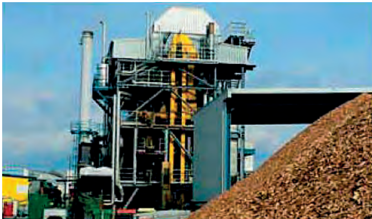
Elektrárna spalující dřevní odpad (Rakousko). Foto: Karel Srdečný, EkoWATT
