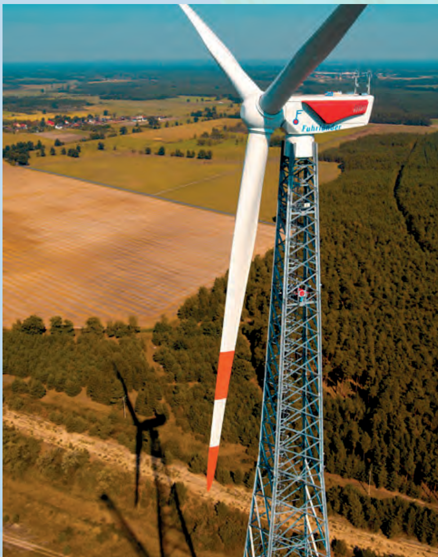
Obr.2.47 Příhradový stožár. Zdroj: http://www.csve.cz .
