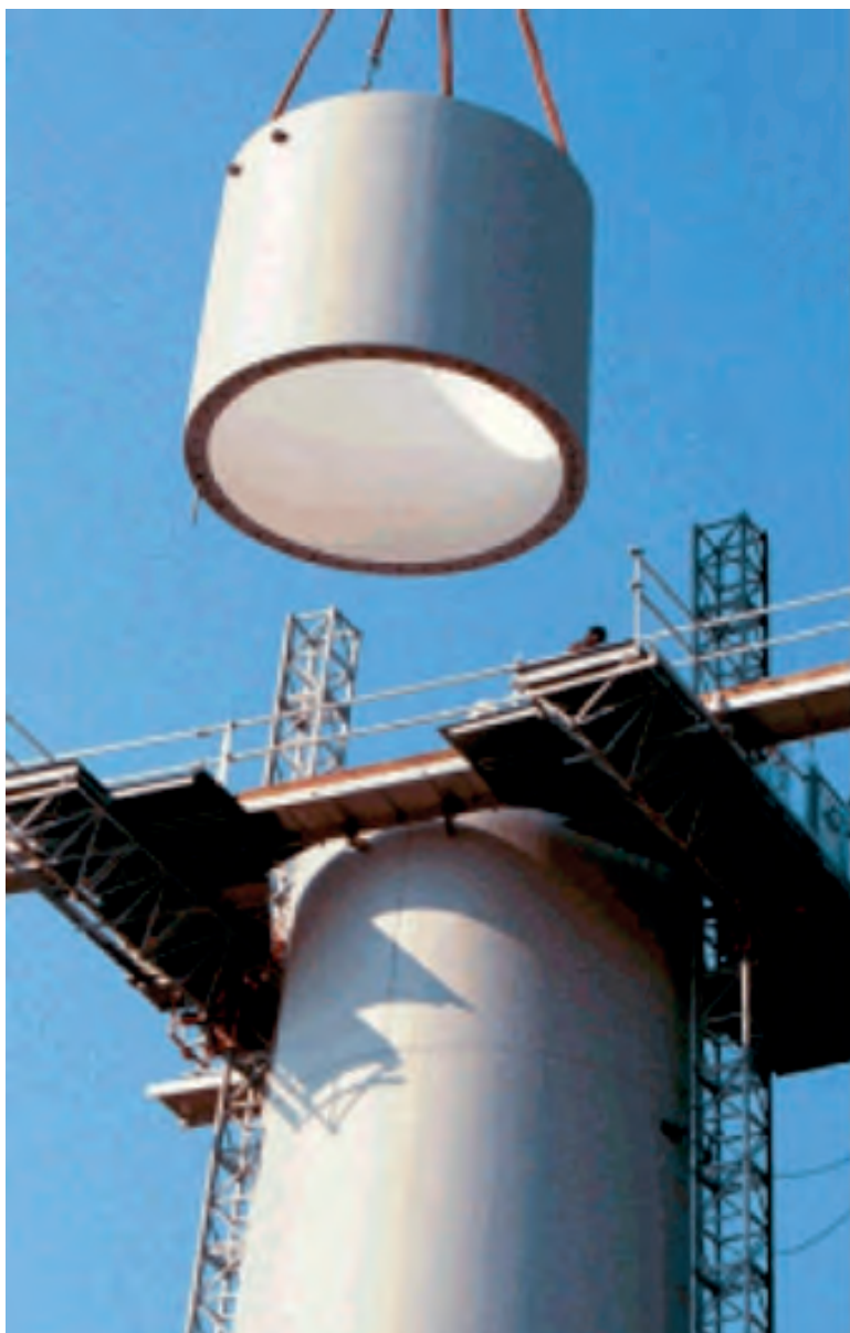
Obr.2.48 Betonový stožár. Zdroj: http://www.csve.cz .
