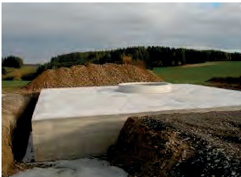
Obr.2.51 Betonový základ. Zdroj: http://www.csve.cz .
