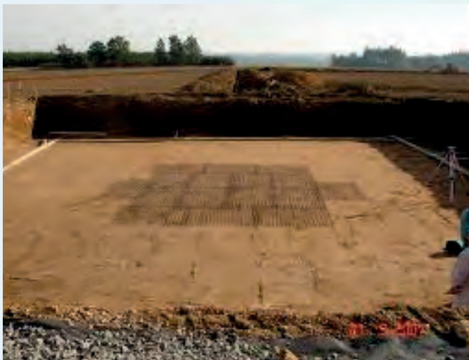
Obr.2.49 Základ pod stožár. Zdroj: http://www.csve.cz .
